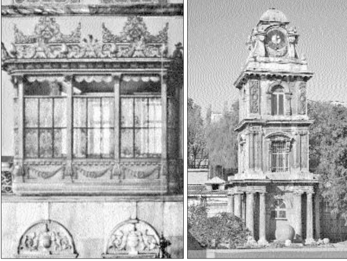
Nusretiye Camii hünkâr mahfilî ile Saat Kulesi
